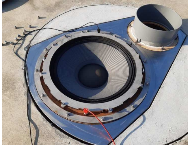
Figure 6 Rondelle d'appui en position
